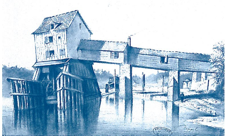
Dessin de François-Julien DECOURBE (1810-1889). Le moulin Saint-Sauveur en aval du Pont-aux-Moulins (1838).
