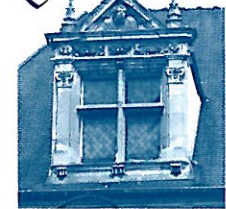
Détail d'une fenêtre
